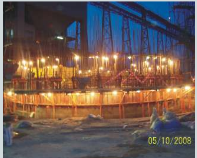
Day & Night non stop progress
